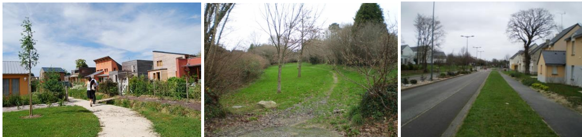
Exemple de cheminements doux, agréables à emprunter
