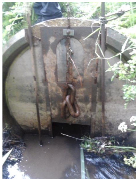
Photo 1 : Vannage sur le cours d'eau de Pen Ar Stang
